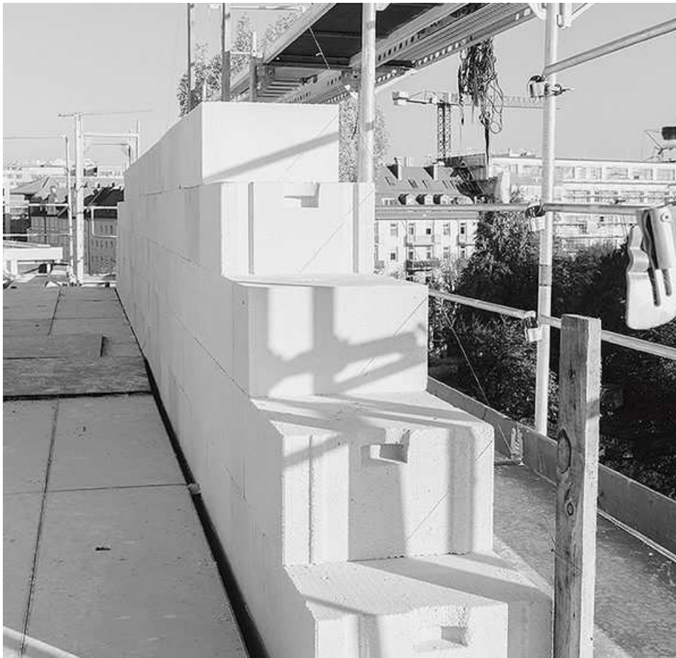
Die seitlichen Griffaschen erleichterten die Handhabung der Porenbetonsteine.
